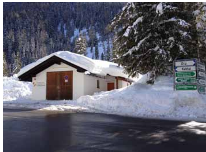
In unmittelbarer Nähe zum bestehenden Gebäude wird einige Meter rechts der Neubau errichtet werden.
