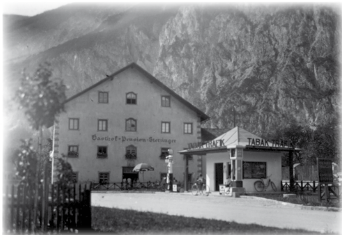
Der Gasthof Sterzinger an der alten Reichstraße, die über Magerbach nach Roppen führte - rechts auf dem Bild sieht man die Tankstelle von Johann Schilcher (vor 1937) (Fotos: oben Nachlass Anton Plankl, re. Archiv Manfred Wegleiter)
