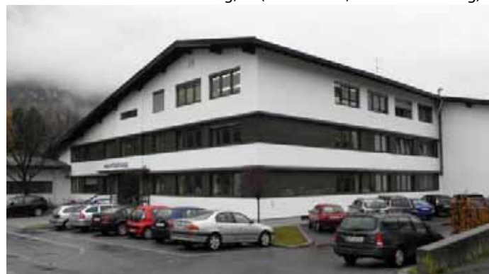
In den letzten Jahren wurde der Oberlandsaal zum Problemfall.
