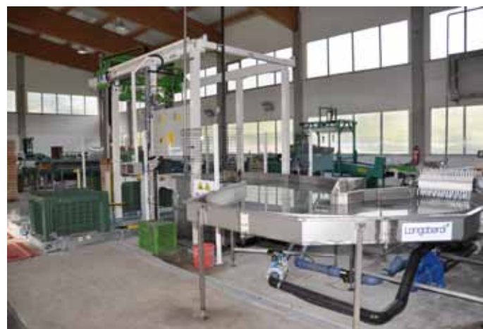
Die neue, für Äpfel besonders schonende, Sortieranlage im Obstlager.
