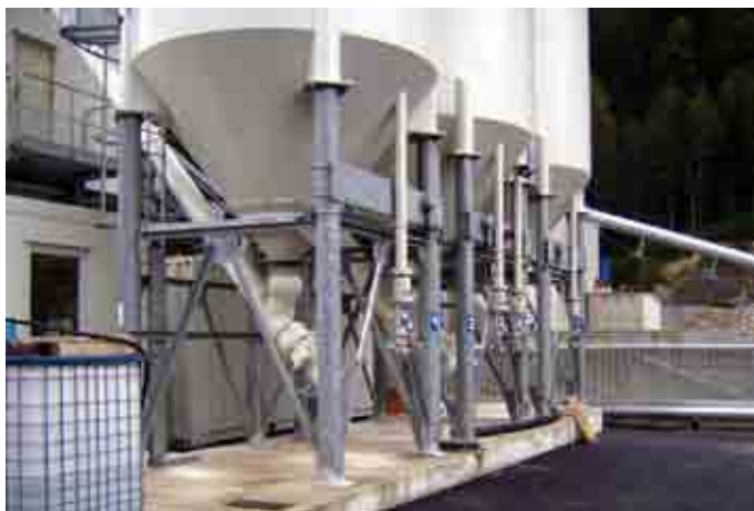
Mit dem Inhalt dieser Betonsilos könnte man mehrere Häuser bauen.
