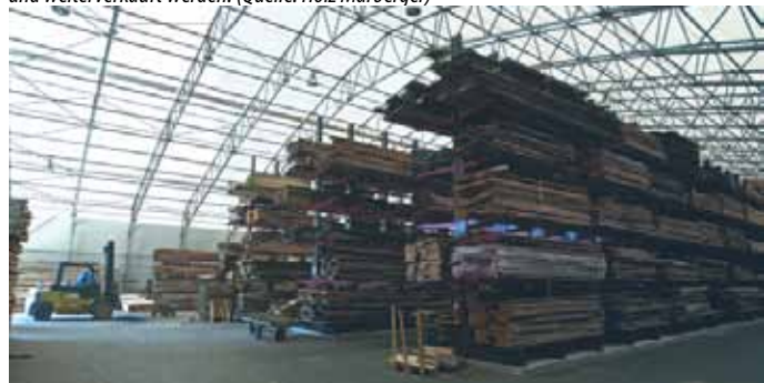
Die moderne Halle in Leichtbauweise ist ideal für die Holzlagerung.
