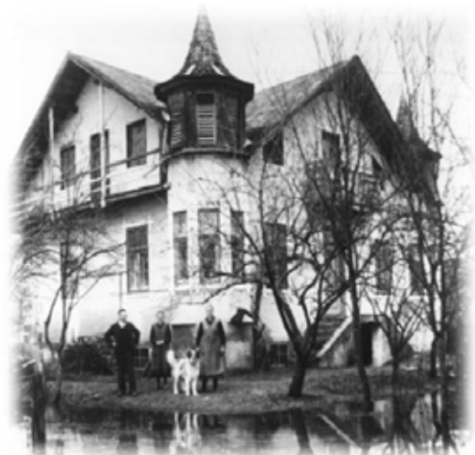
Wohnhaus in der Ötztalerstraße Nr. 10: Das Wohnhaus wurde inzwischen generalsaniert und die Türme abgerissen.
