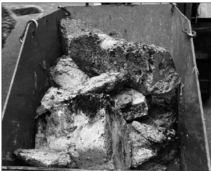
Fettstöcke beim Ablasswehr im Fettfang. Das Bild entstand durch den Abwasserverband Achensee-Inntal-Zillertal.
