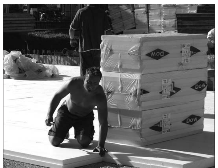
Sandro Kleewein bei schweißtreibender Arbeit auf der Baustelle "Seniorenheim". Die Arbeiten schreiten zügig voran, das Haus soll im November 2008 bezugsfertig sein.
