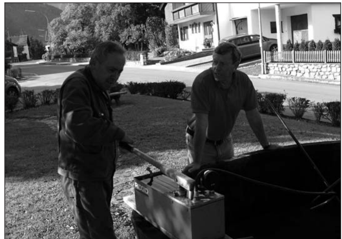
Wassermeister Helmut Leitner bei der Leitungssäuberung am Brunnen beim Wammes. Im Bild mit Viktor Raffl.
